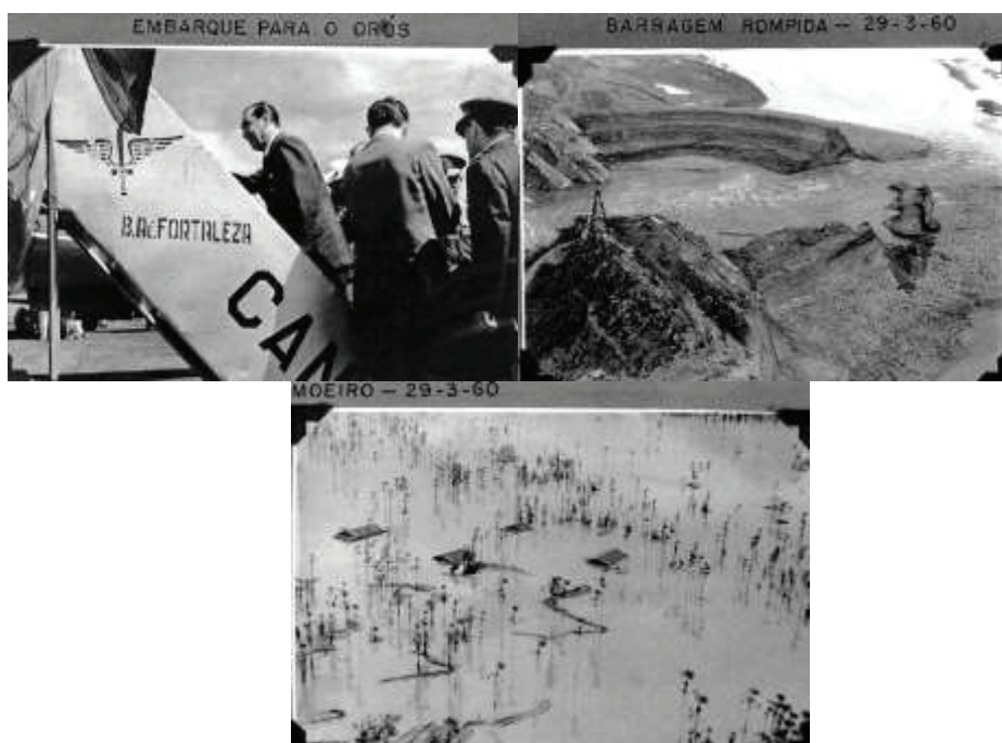
Figura 3 - Transbordamento do reservatório.
