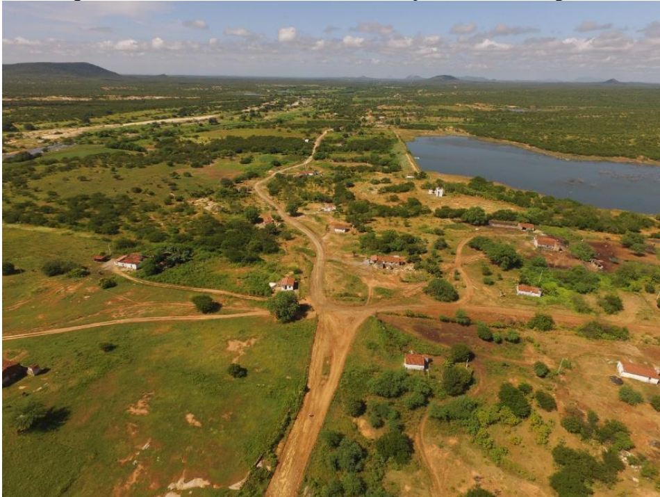
Figura 7. Fotografia aérea das Comunidades abastecida pelo Sistema Integrado do Boa Vista
