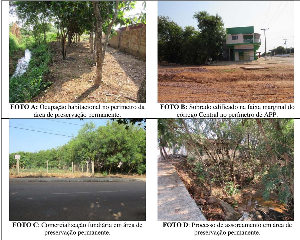
Figura 4 – Ocupação habitacional irregular em faixa marginal do córrego Central destinada a preservação permanente conforme Lei Federal nº 12.651/2012 - Nova Canaã do Norte- MT/Setembro de 2018
