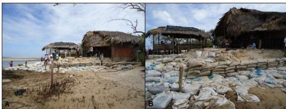
Figura 03 - Restaurante construído na Ilha do Cajueiro, município de Tutóia – MA, em área de manguezal sendo destruído pelo avanço do mar.
