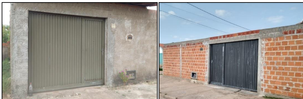
Figura 5 – Modificações nas moradias do Conjunto Habitacional São Luiz
