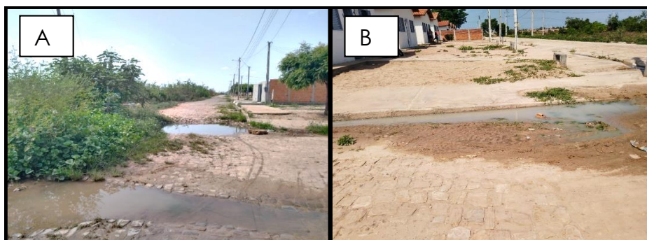
Figura 3 – 3A: águas residuais das residências no Conjunto Habitacional São Luís; 3B: águas residuais das residências no Conjunto Prefeito César Leal
