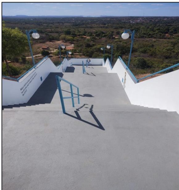
Figura 15 - Infraestrutura de apoio aos visitantes no Geomorfossítio Mirante do Morro da Cruz
