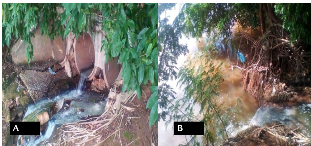
A: Bueiro que despeja o esgoto; B: Esgoto sendo despejado no rio Parnaíba. Fonte: Nascimento (2018).
